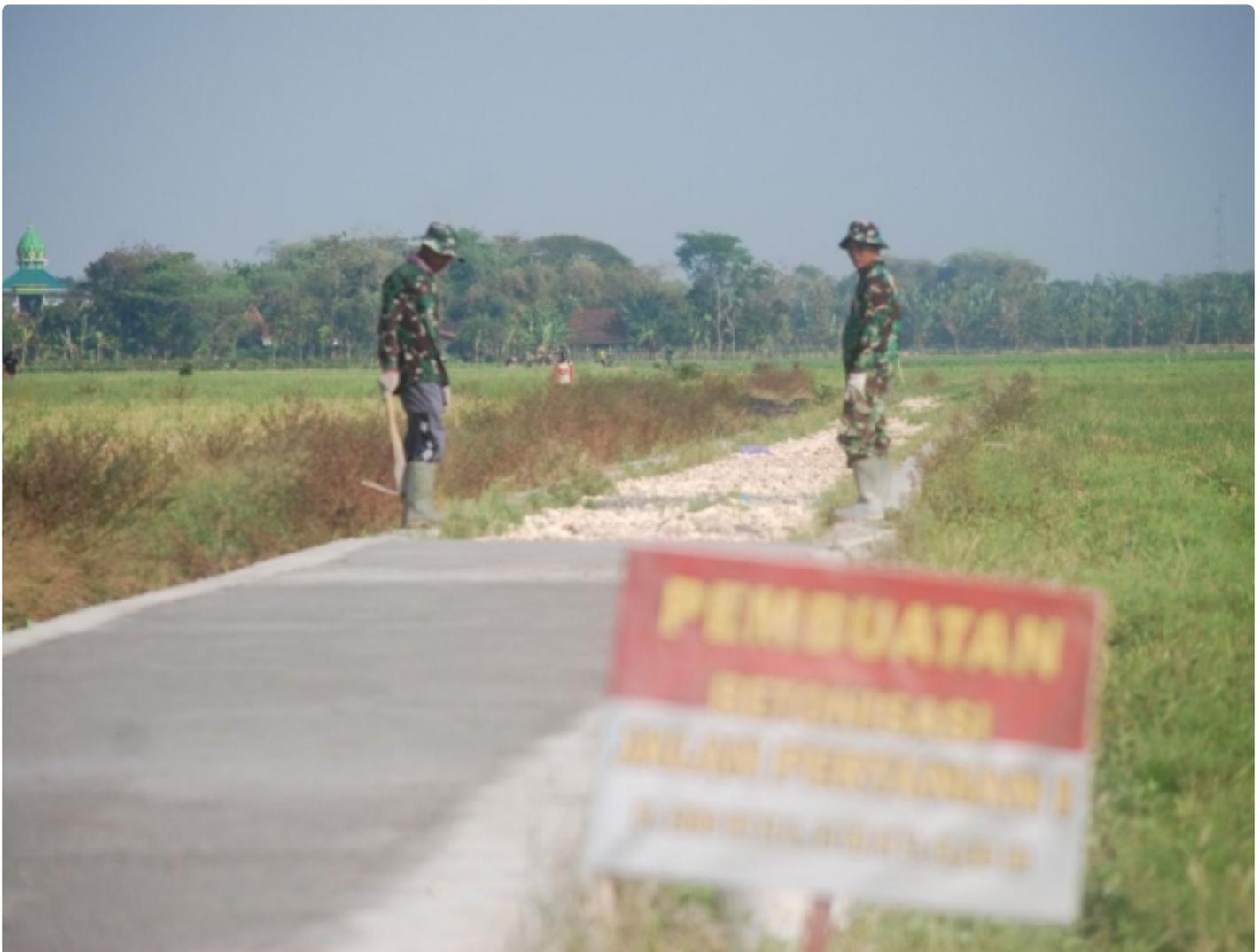
*Tentara Nasional Indonesia (TNI) Membantu Pembangunan Jalan Pertanian Sepanjang 200 Meter Lebar 2 Meter Dan Tebal 0.15 Meter. Ini Merupakan Sasaran ke-2 Pengecoran Jalan Oleh Satgas TMMD Reguler ke 114 Kodim 0716/Demak*
