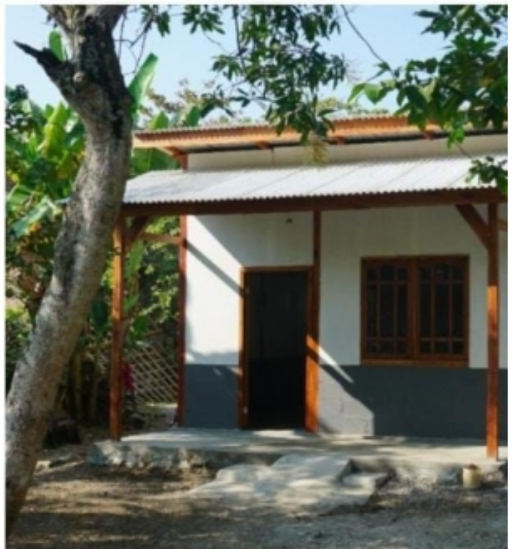
Kondisi rumah Maghfiroh setelah direhab Satgas
